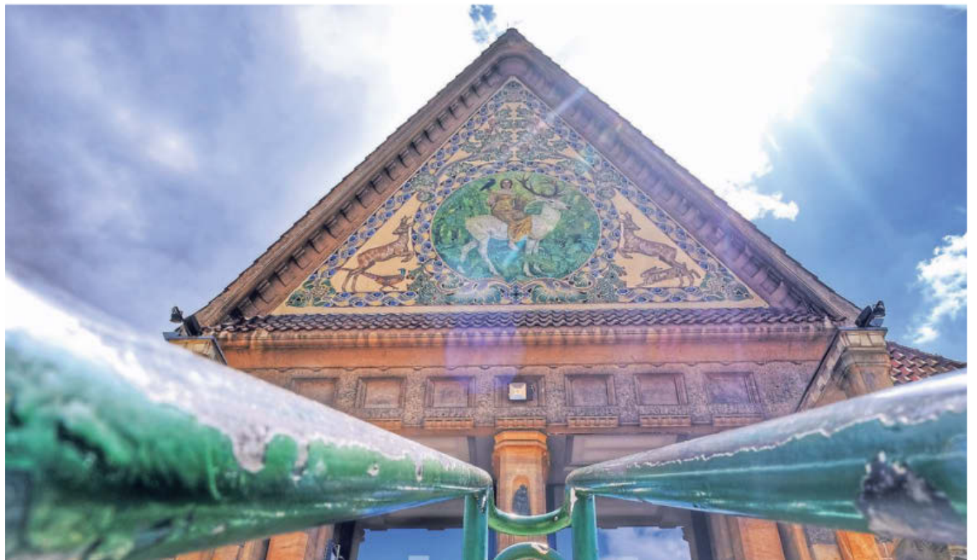
Die Sanierung des Stadtwaldhauses wird mit 7,3 Millionen Euro veranschlagt.
